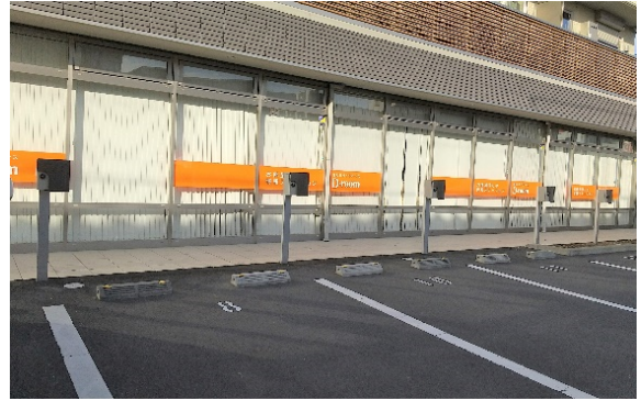
EV充電設備を設置した事業所（東京都足立区）
