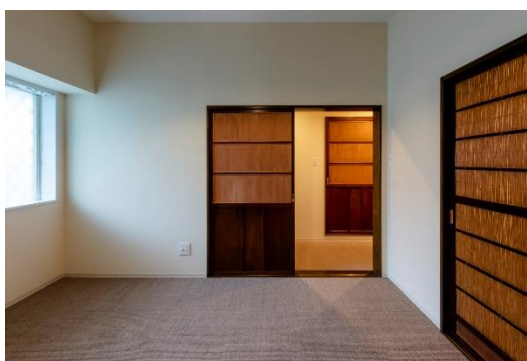
洋室のクロゼット引き戸には風を通す貫戸を使用
