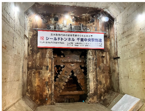
千里中央駅北端部に到達したシールドマシン
