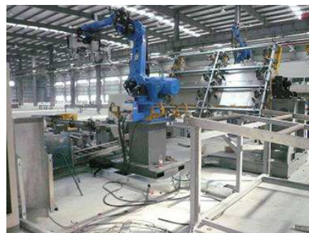
外壁パネル組立・溶接ロボット
